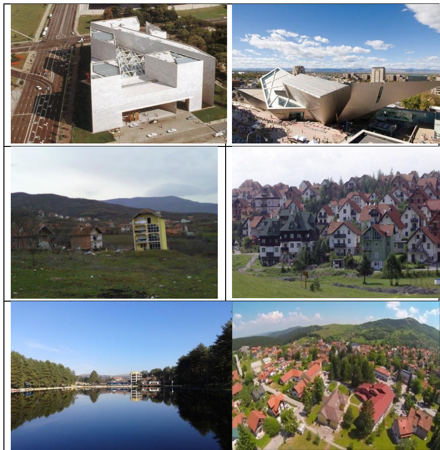
Slika 5. Loša arhitektonska rešenja koja remete izgled predela
